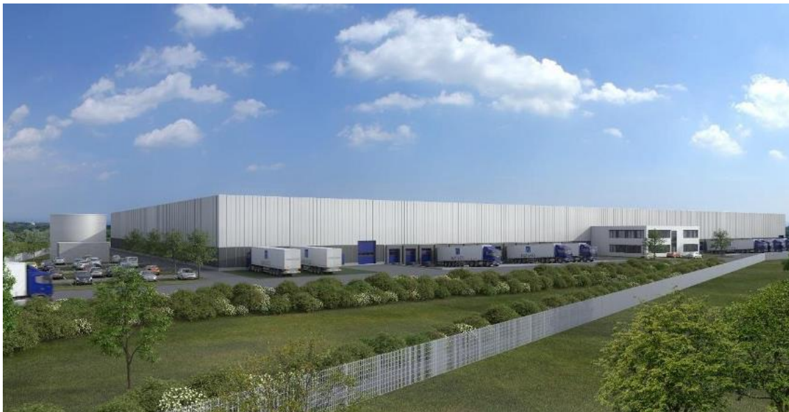
Neubau für die Rudolph Logistik Gruppe, Mamming, Bayern, 30.000 m 2 Logistikfläche, Fertigstellung 2015
