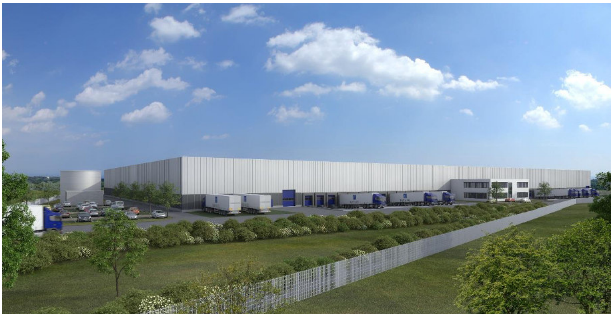
Neubau für die Rudolph Logistik Gruppe, Mamming, Bayern, 30.000 qm Logistikfläche, Fertigstellung Anfang 2015
